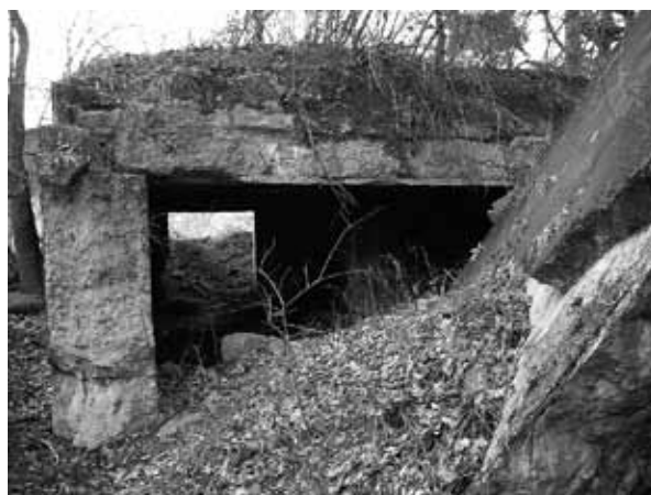
Zachovalá část dělostřelecké pozorovatelny 100 grad po odstřelu (objekt č. 4).
