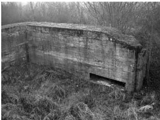
Čelní stěna s lanovým prostupem.
