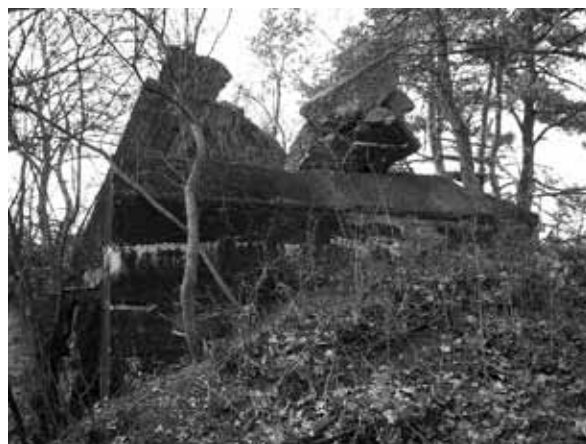
Zkosená hrana stropnice objektu č. 4.
